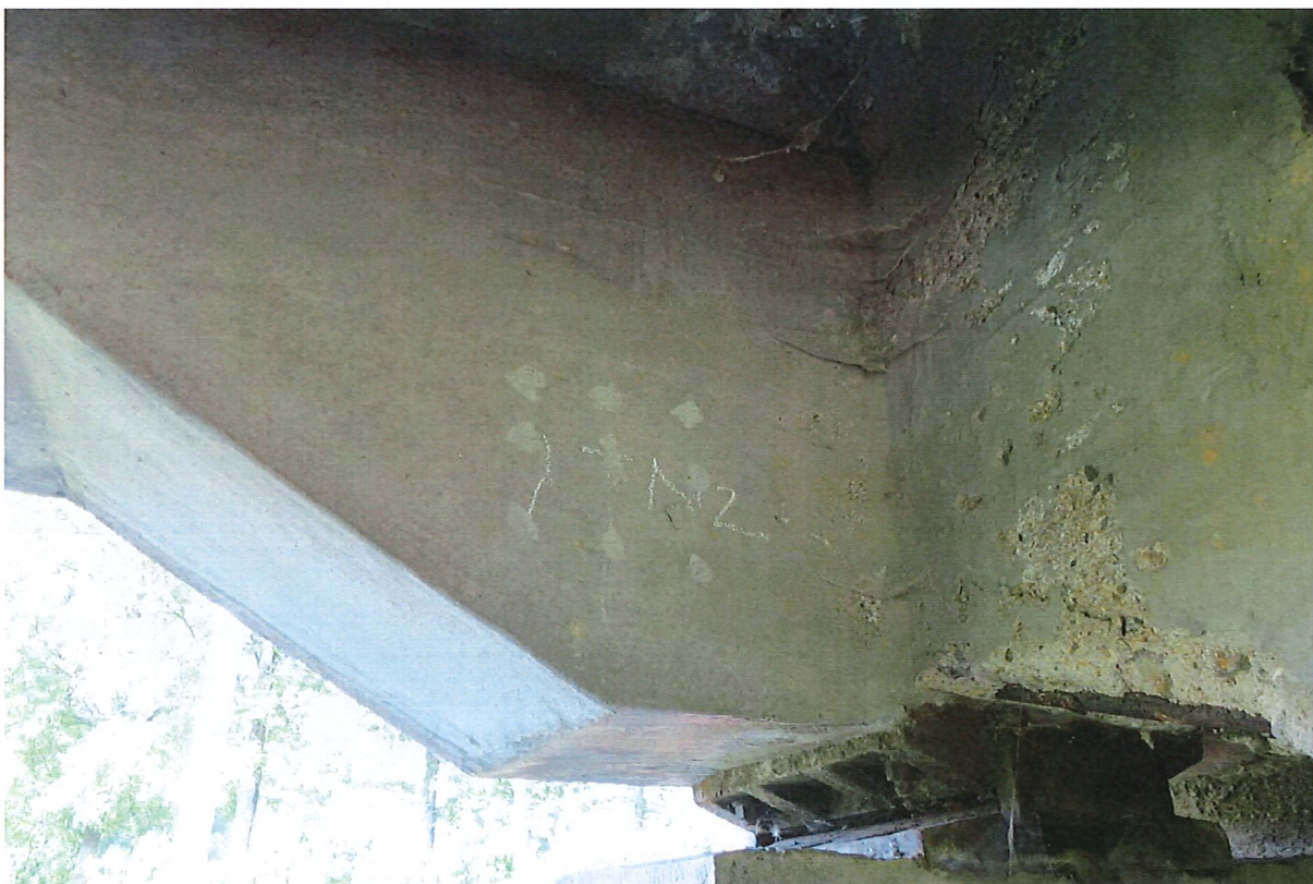
Obr. 12 Zkušební místo na dolním pase hlavního nosníku
