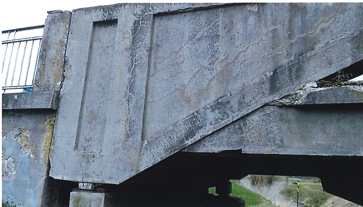
Obr.9 smršťovací trhliny v pohledové omítce oblouku
