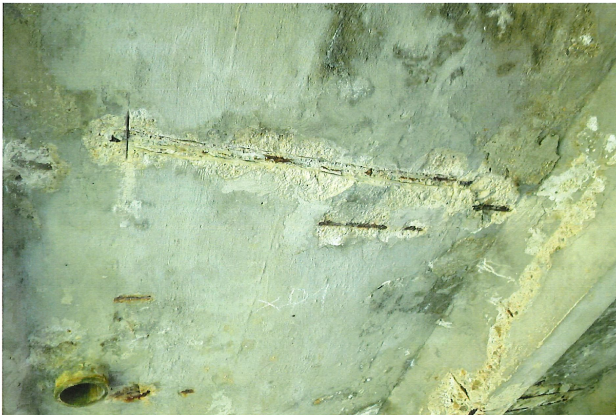
Obr. 19 Místo oděru výztuže pro trhací zkoušky - V1
