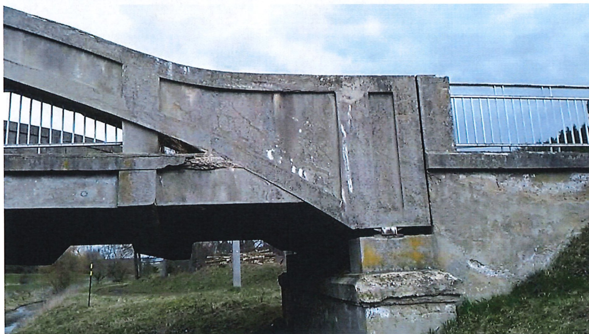
Obr. 6 Pohled na opěru 2 s pevným uložením NK
