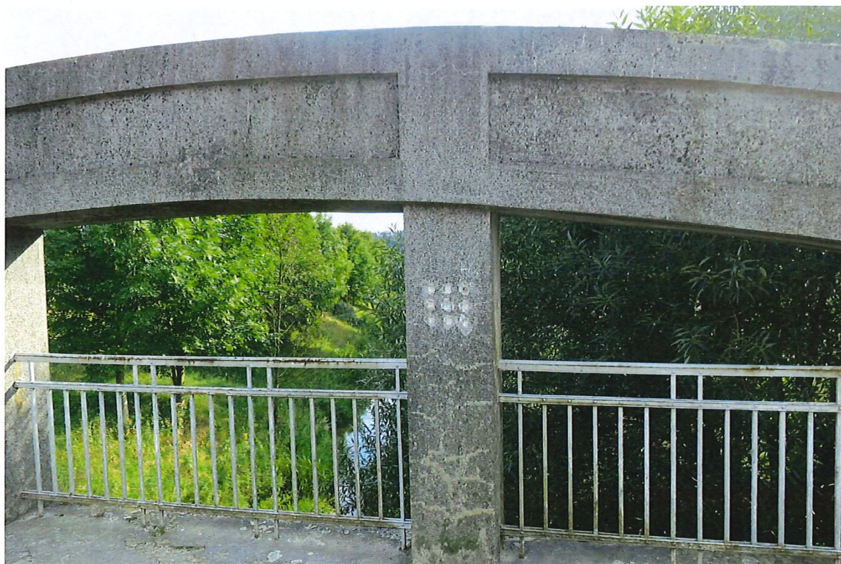
Obr. 15 Zkušební místo závěsu pravého nosníku
