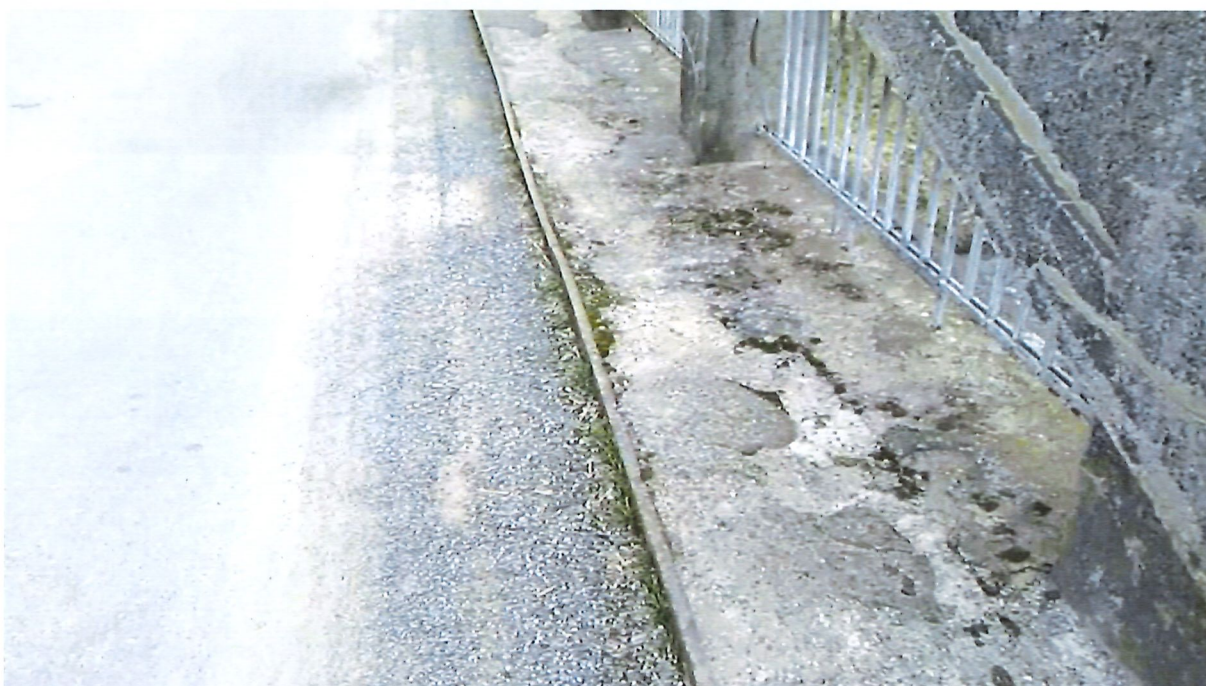
Obr.8 Degradace betonu chodníků a koroze ocelového úhelníku; nánosy na krajnici
