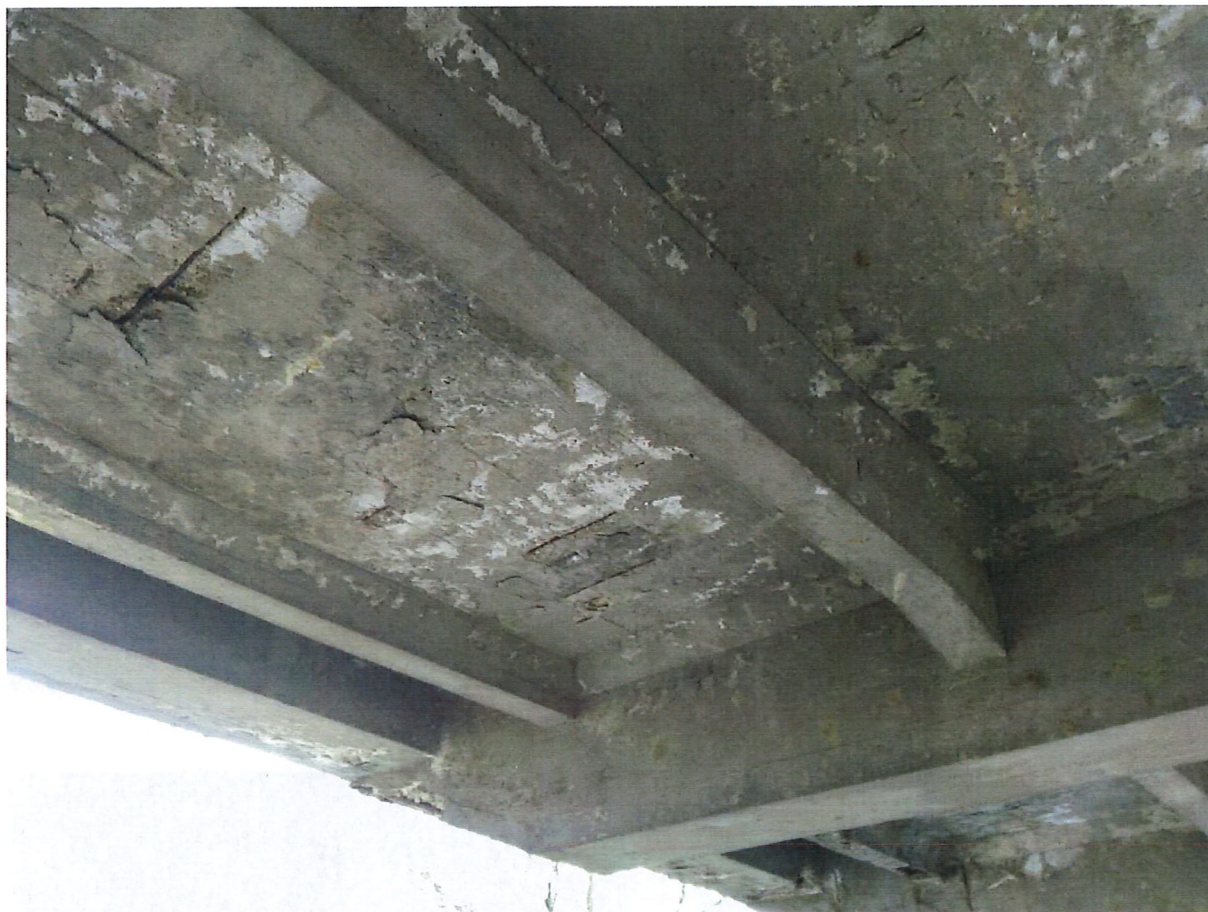
Obr.5 Deska mostovky NK s výluhy a degradací betonu
