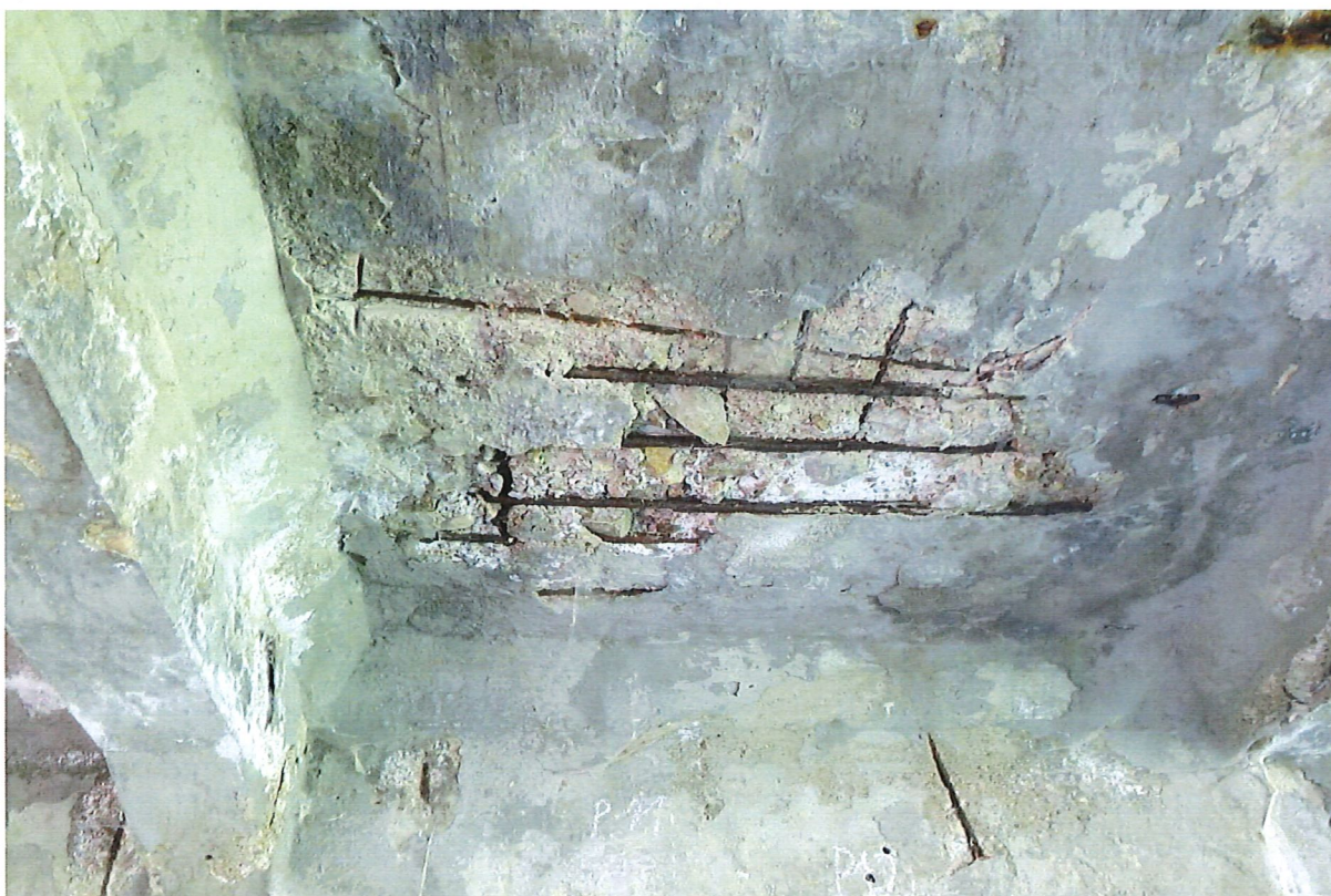
Obr. 20 Místo oděru výztuže pro trhací zkoušky – V2
