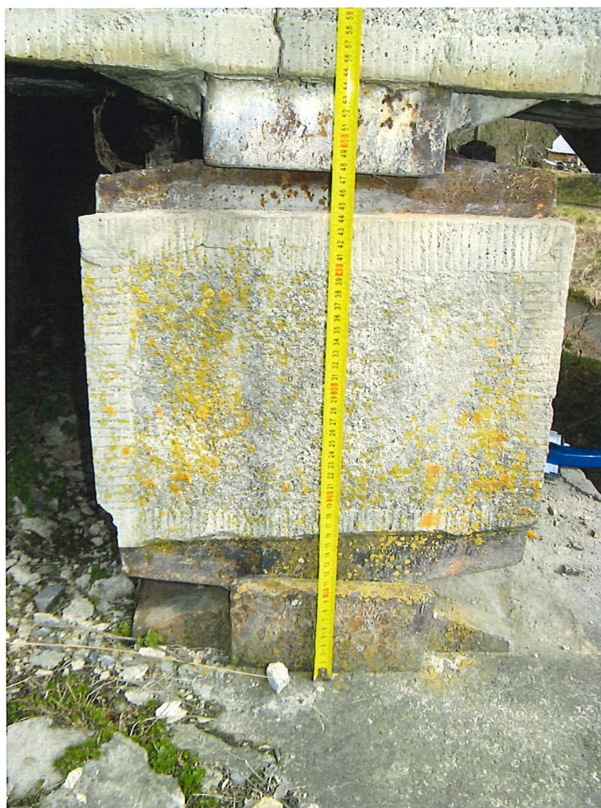
Obr.10 Pohled na pravé kyvné ložisko opěry1; koroze ocelových částí, degradace betonu ložného prahu
