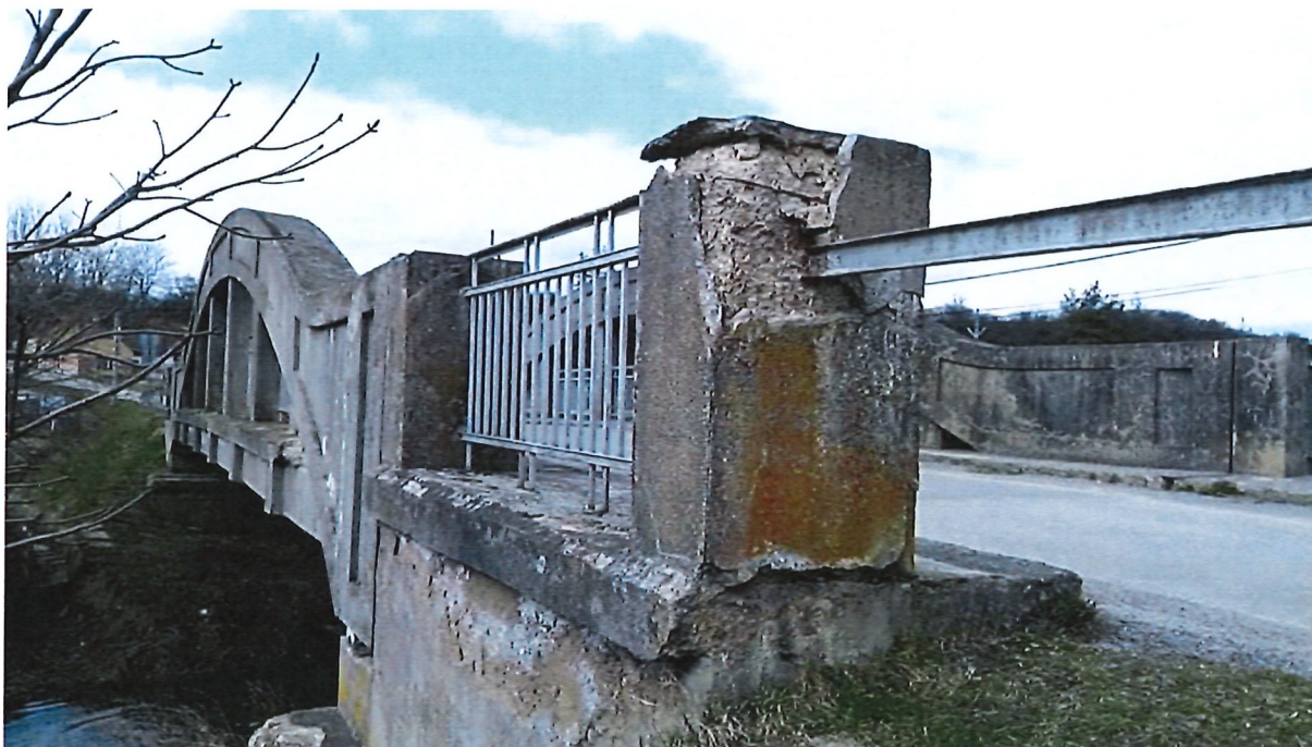
Obr. 7 Konce křídla opěry 2, napojení záchytného systému
