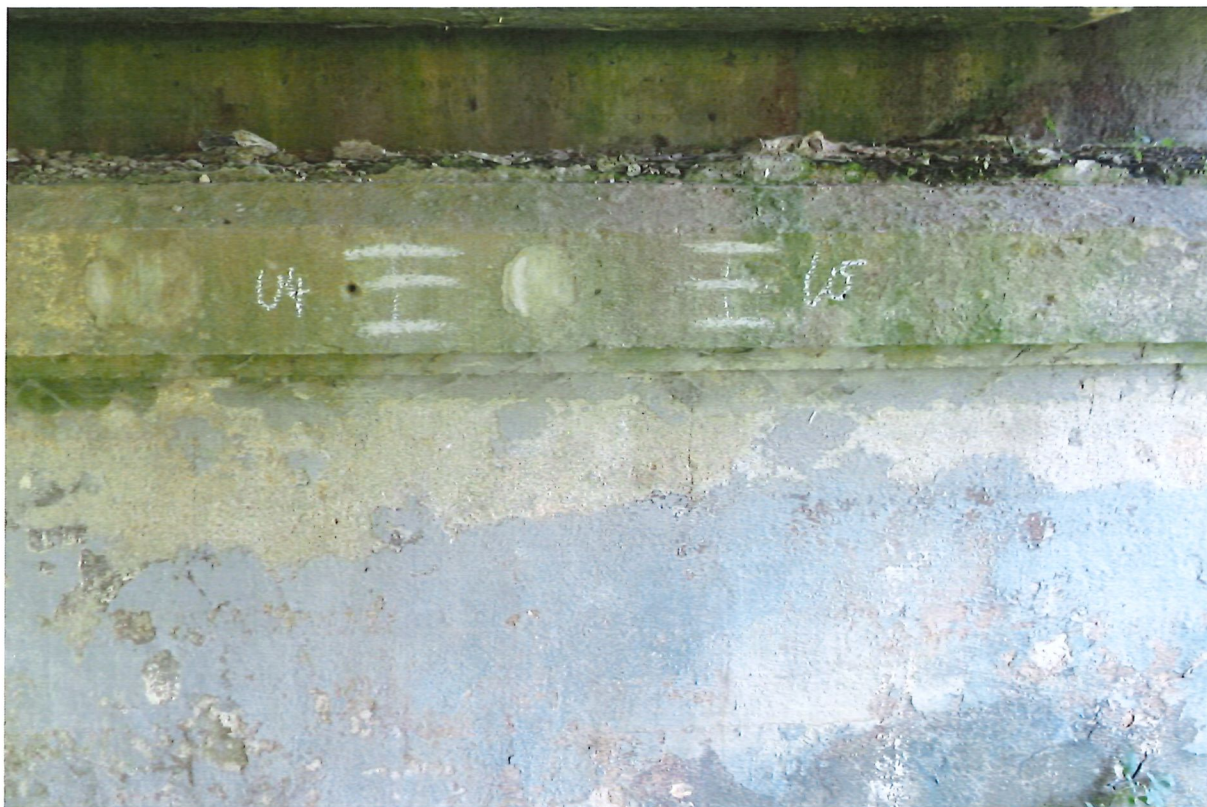
Obr. 17 Zkušební místo na úložném prahu opěry 1 (směr Radotice)
